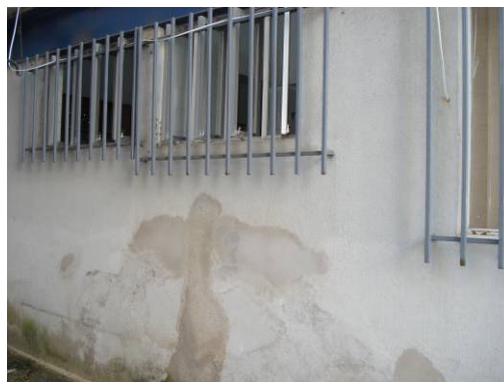
(b) Infiltração por quebra de cano PVC da cozinha.
