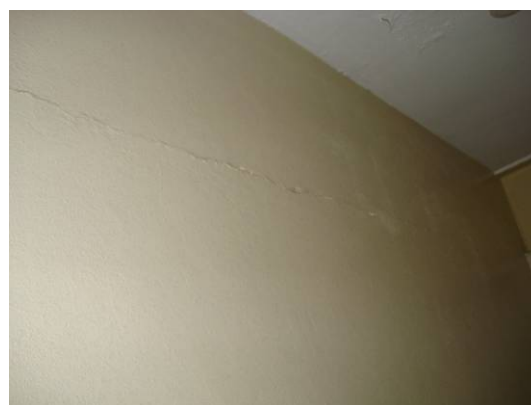
(b) trincas entre estrutura e parede
