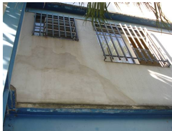
(a) Infiltrações do 1º pavimento
