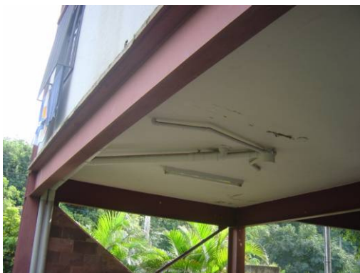
(a) Instalações hidrossanitárias aparente.
