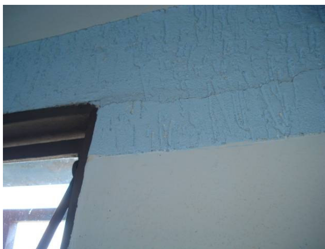
Figura 5.34 – Esquadrias e problemas na junta vedação
